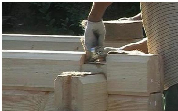
3. Надежно установив деталь на земле, определяем глубину засверливания согласно "Схемы определения глубины засверловки"
