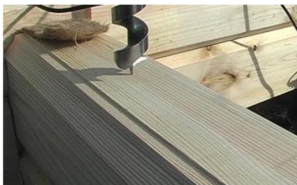
Засверливаем отверстия специальным комбинированным сверлом.
