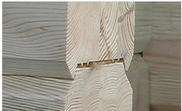
6. Вворачиваем Пружинные узлы СИЛА до полного устранения зазора в межвенцовом посадочном месте.
